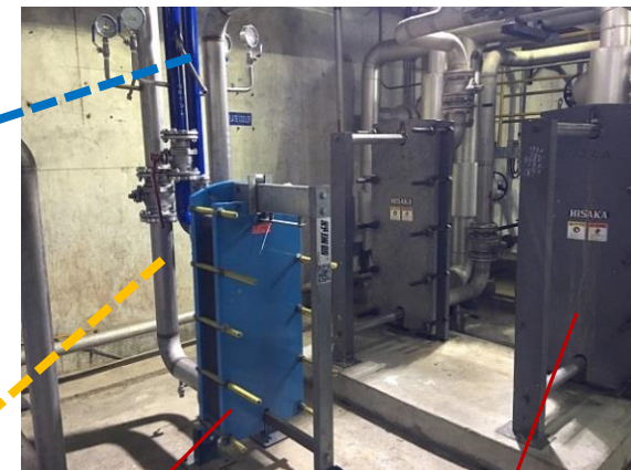
新設冷卻水板熱器
